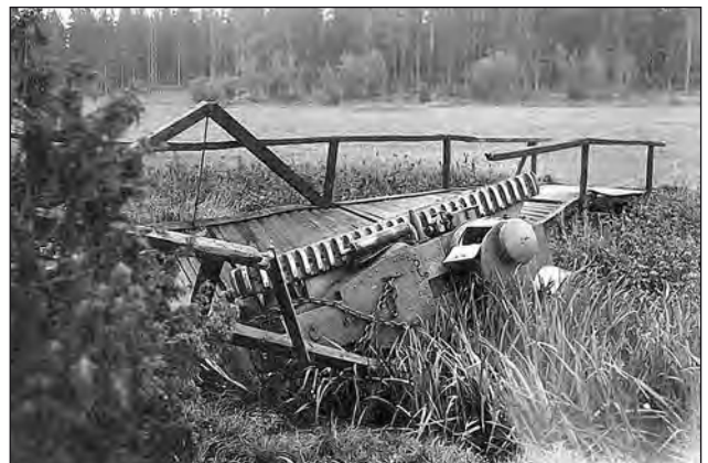
20. ábra. A francia Renault NC-27, svéd nevén Strv fm/28 az egyik próbája során, patakba borulva. Svéd kezelői nehezen kormányozható és megbízhatatlan típusnak tartották
